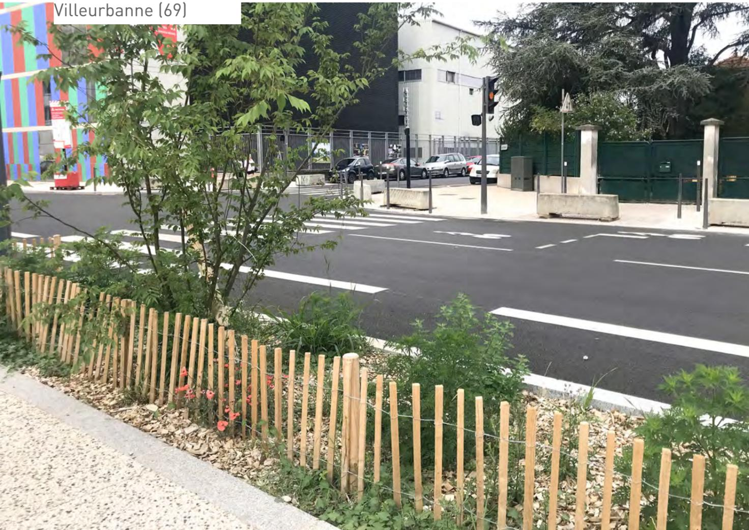
Le projet vise à requalifier l'avenue Decorps pour encadrer le stationnement et intégrer les modes actifs. Grâce à un **profil asymétrique pour créer un large trottoir en béton désactivé encadré d'une double bande plantée.**
